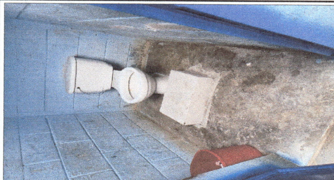
Adaptación de grada a sanitarios para que sean aptos para niños de preprimaria
