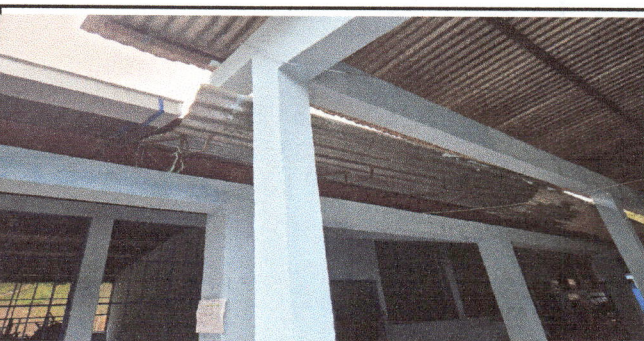
Sustitución de canal en mal estado y de mal aspecto
