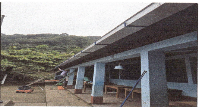
Cambiando canal de aguas pluviales deteriorado
