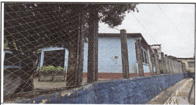
Proceso del cambio de malla perimetral
