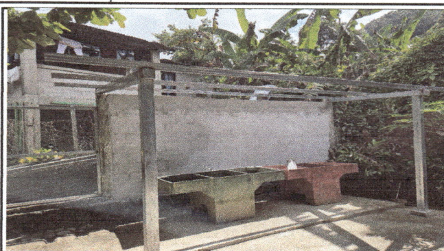
cambio de galera para pilas
