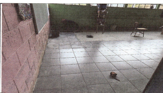
Piso de las aulas, cambio de entortado por piso cerámico
