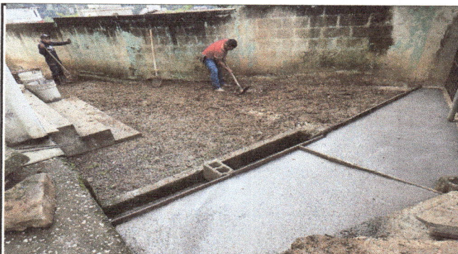
Salida hacia los baños de niñas, procediendo a hechar entortado de cemento
